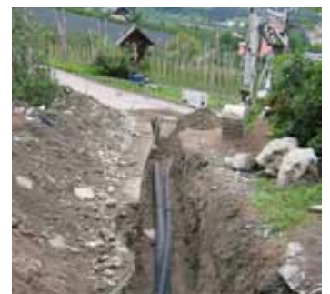
Bau Abwassersammler Eggerhöfe bis Lahnweg
